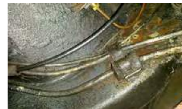
Repérage des conduites sous le plancher.
