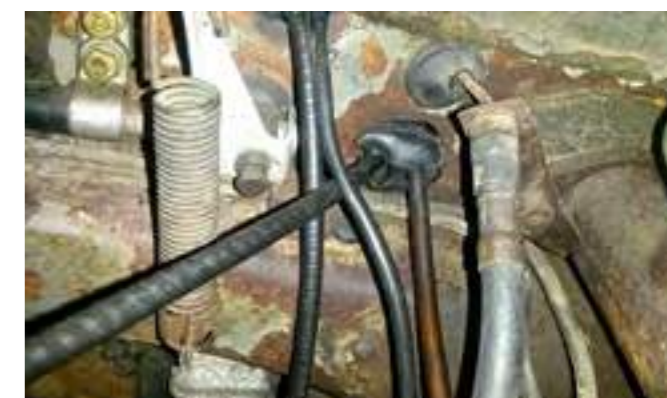
Repérage des sorties de câbles et commandes dans le tablier avant.
