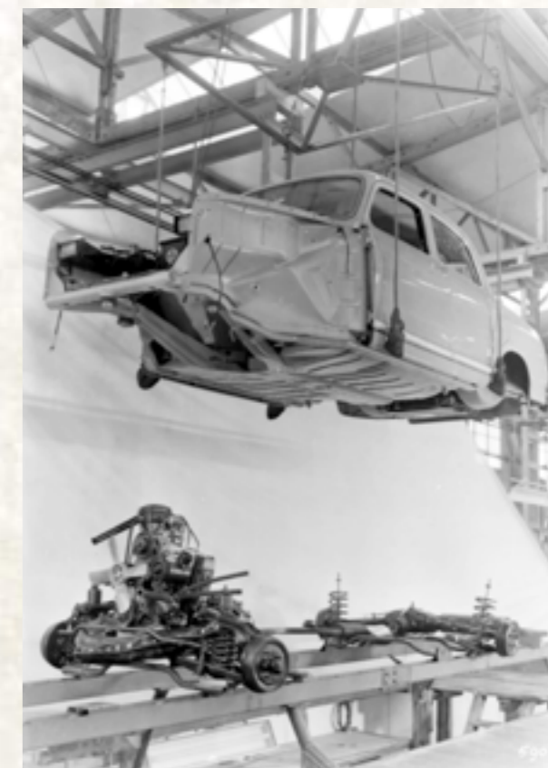
La révolution technique de la ponton : une carrosserie monocoque s'appropriant à recevoir ses organes mécaniques sur la chaîne d'assemblage.
